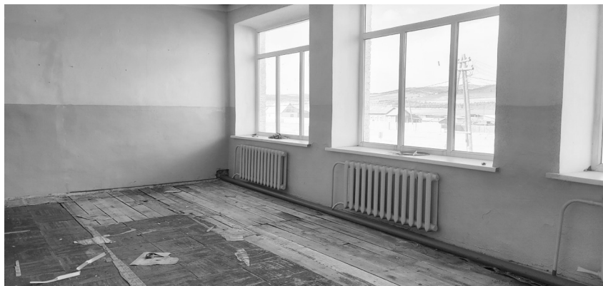
Кодунская СОШ. До ремонта
