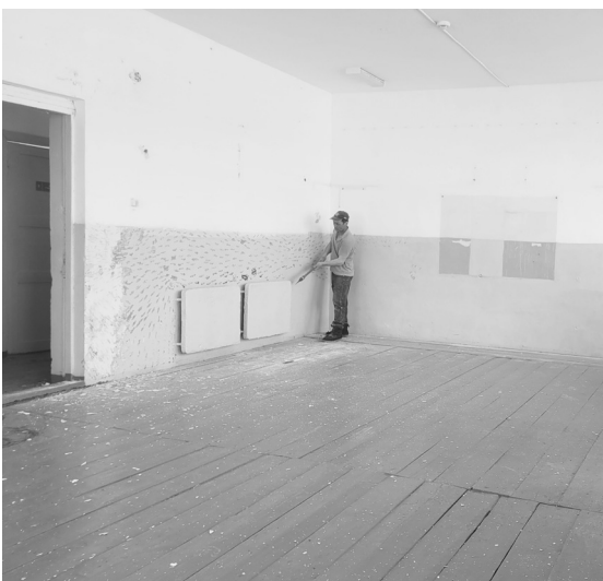
Кодунская СОШ. До ремонта
